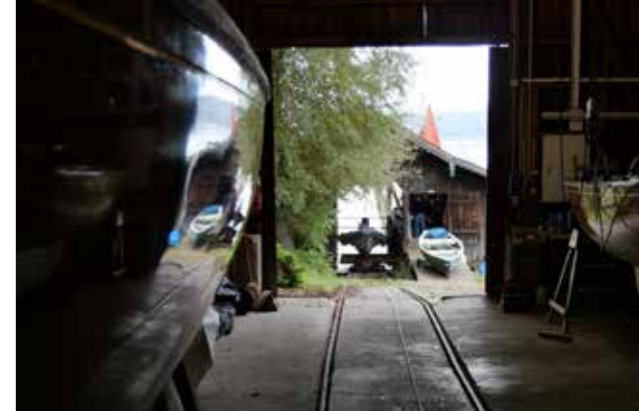
Slip-Schienen vom „Oberem“ durchs „Untere Bootshaus“, 2020 / cme
